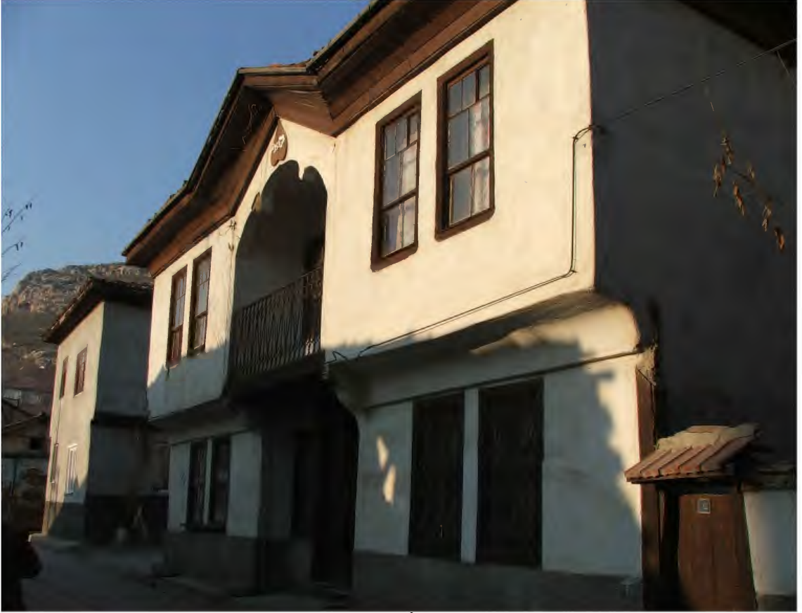
Resim 8: Bozüyük- Kasımpaşa Mah. Hacı İbrahim Sok. No:12
