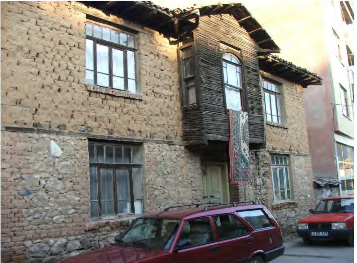
Resim 13: Bozüyük- Kasımpaşa Mah. Hacı İbrahim Sok. No: 2
