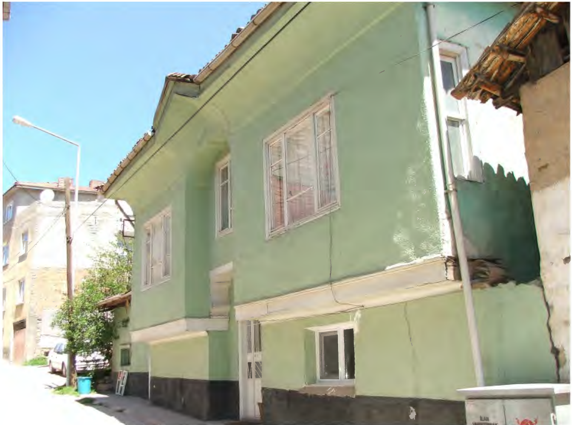
Resim 41: Bozüyük-Kasımpaşa Mah. Aşçılar Sok. No: 34
