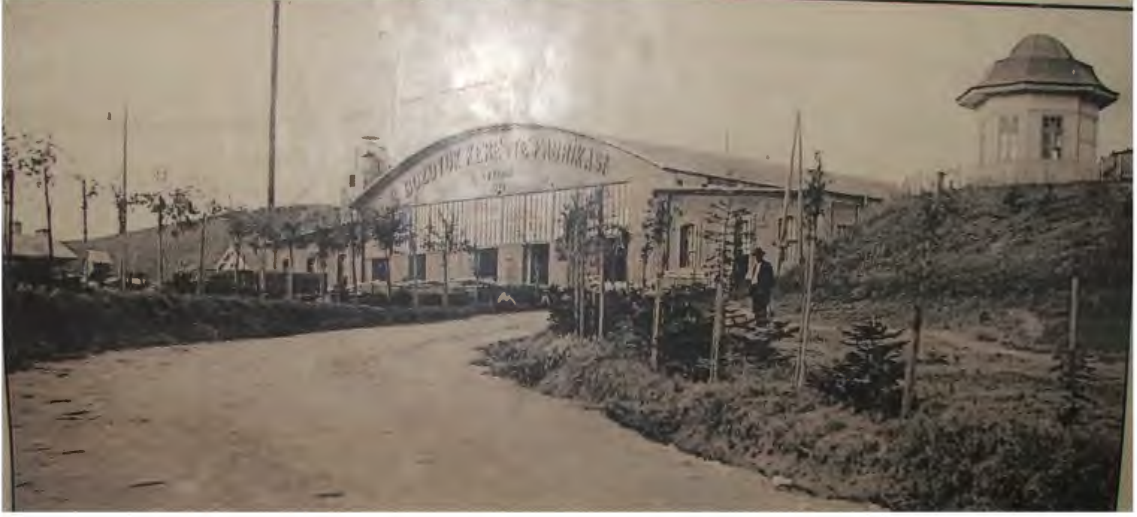
Resim 53: Bozüyük Kereste Fabrikası
