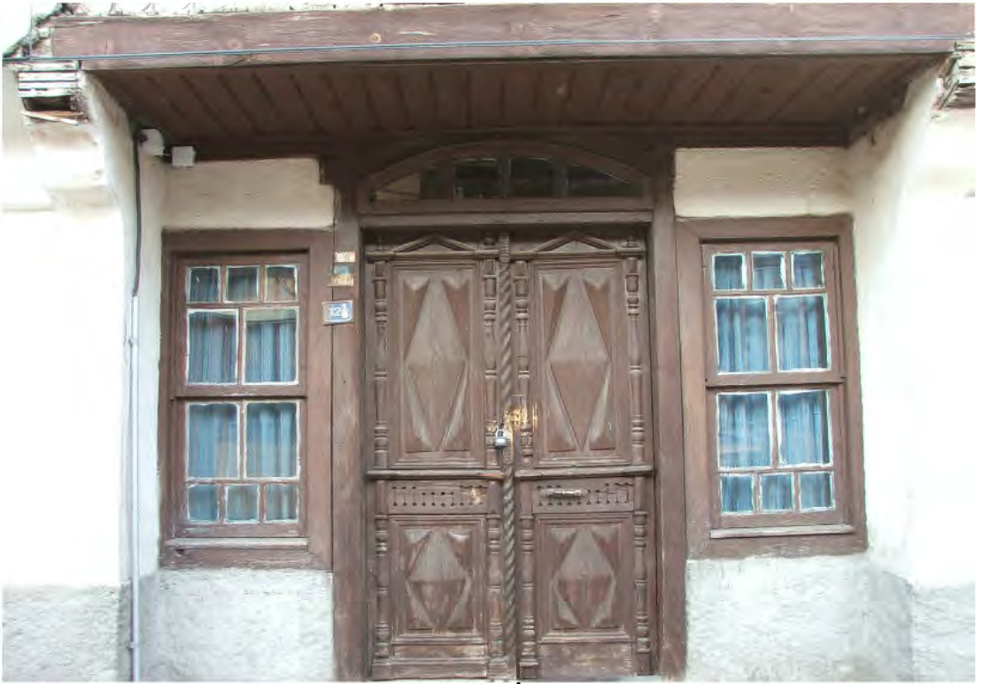
Resim 1: Bozüyük- Kasımpaşa Mah. Hacı İbrahim Sok. No:12
