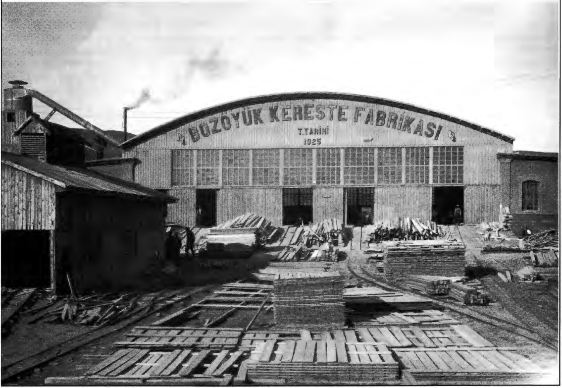
Resim 51: Bozüyük Kereste Fabrikası
