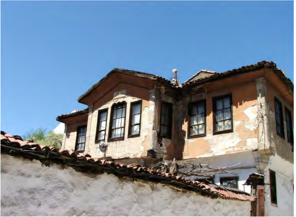
Resim 32: Bozüyük-Kasımpaşa Mah. Aşçılar Sok. No: 23
