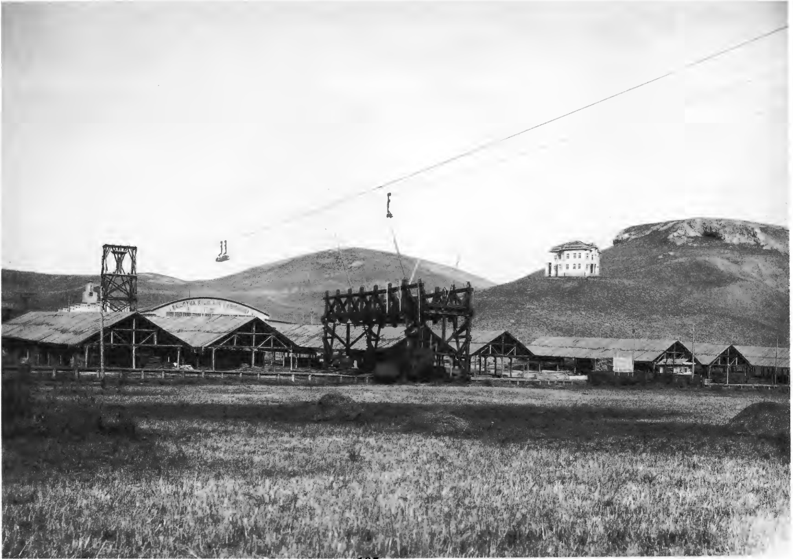
Resim 52: Bozüyük Kereste Fabrikası 105
