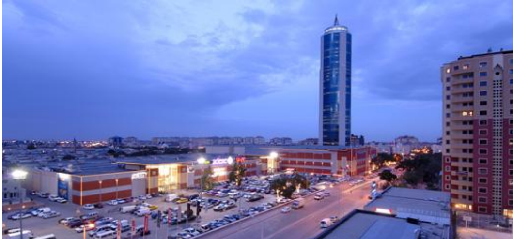
Şekil 3. KuleSite AVM’nin Genel Dış Görünüm Fotoğrafi
