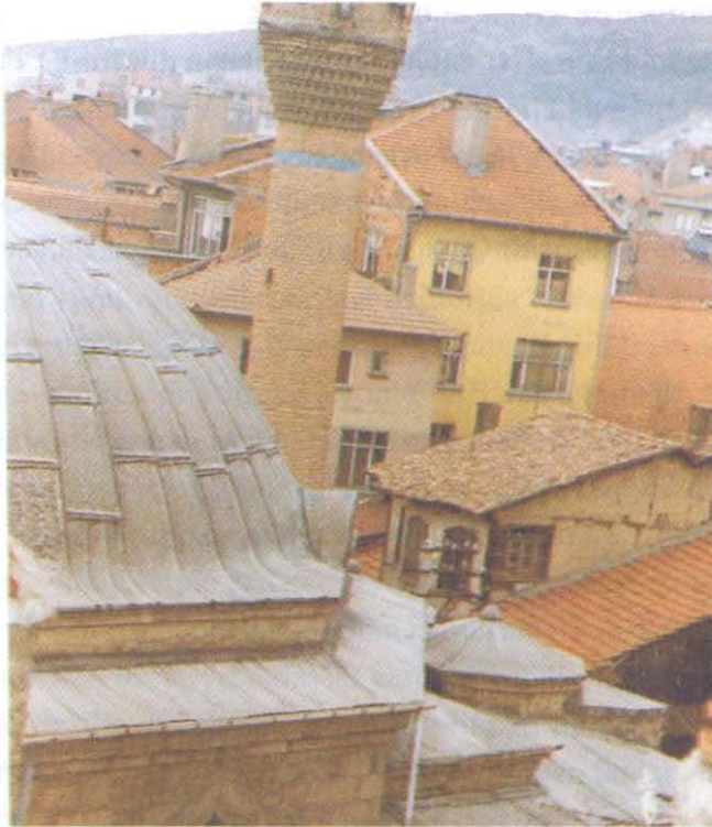
Resim 2. Kütahya – Tavşanlı Kurşunlu Camii Kubbe Geçiş
