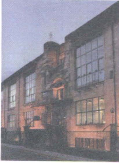
Resim 12-a Taş yapının ön cephesinde bulunan demir korkuluklar yapının görsel ağırlığını hafifletmektedir. Kaynak: Pevsner, Pioneers of Modern Design, 1964
