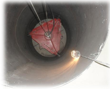
Görsel 2.10. İndüksiyon ocağının yan duvar dövülmesi
