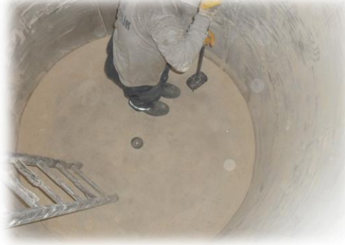
Görsel 2.7. İndüksiyon ocağının tamamlanan taban astarlaması sonrası şişlenen bölge
