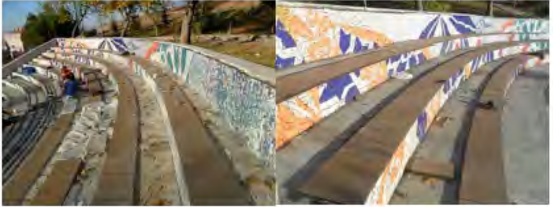
Görsel 95. Oturma elemanlarının yerleştirilmesi
