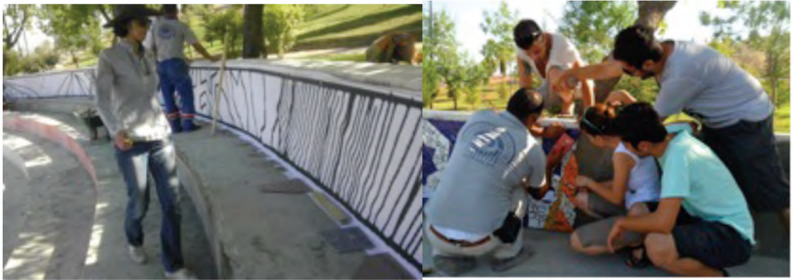
Görsel 93. Fileye yapıştırılan mozaiklerin yerleştirilmesi.
