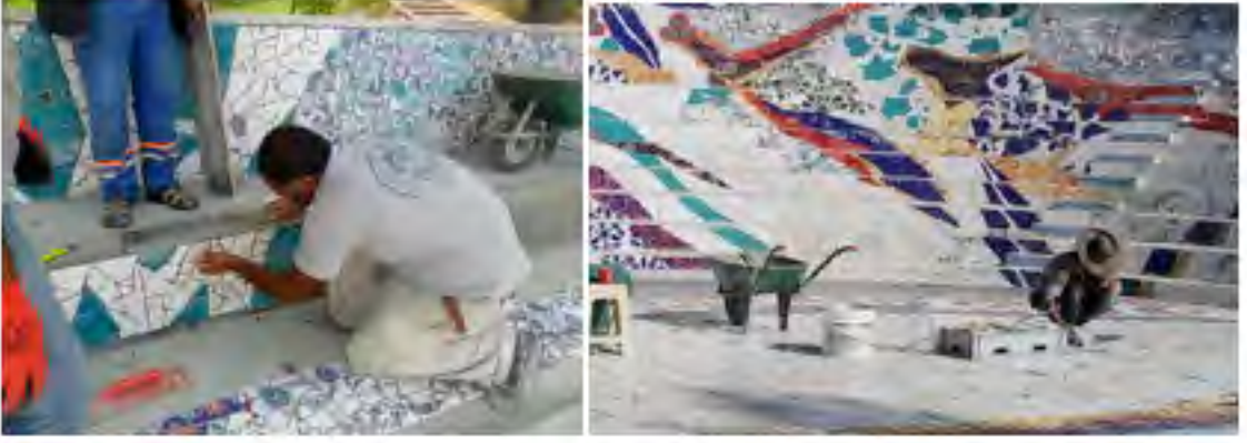
Görsel 94. Amfinin derz dolgusunun yapılması.
