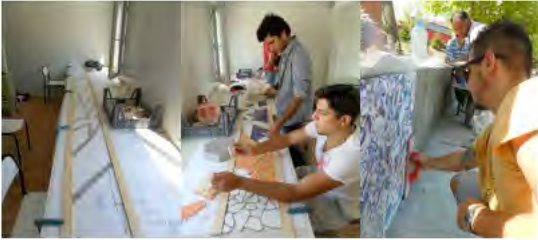
Görsel 45. Dolaylı uygulama yönteminin derz dolgu aşamaları, 2014.
