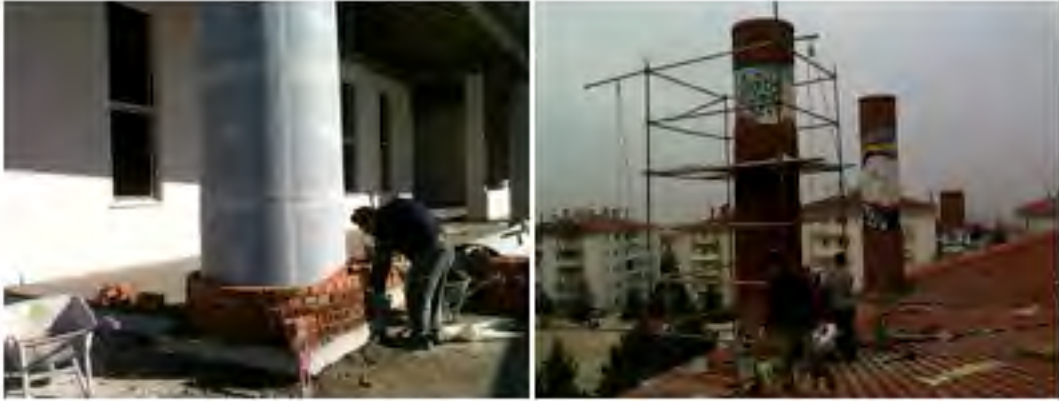
Görsel 99. Müze binası bacalarının inşasından görüntü.
