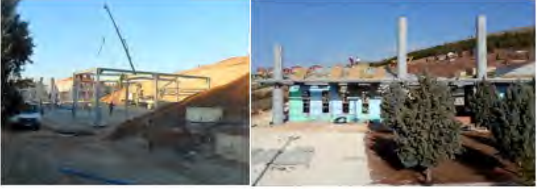
Görsel 98. Müze binasının inşa çalışmalarından görüntü.
