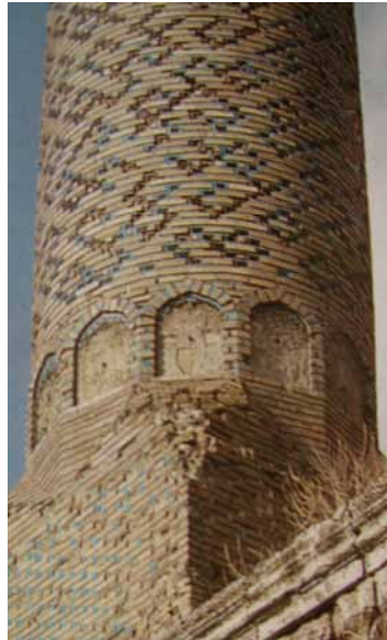
Resim 2: Sivas Çifte Minareli Medrese Minaresinde Firuze ve Mor Sırlı Tuğla Bezeme, 1272 Gönül Öney, İslam Mimarisinde Çini, 1987, s.49
