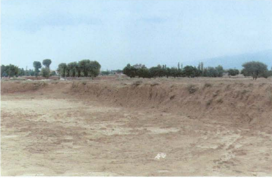
Resim 4: Hafriyat Bölgesindeki Yarma Kalınlığı
