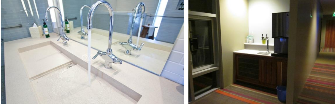
Görsel 3.12a. H2hotel’in Düşük su akışı sağlayan armatürler, 12b. Su istasyonları (http-17)
