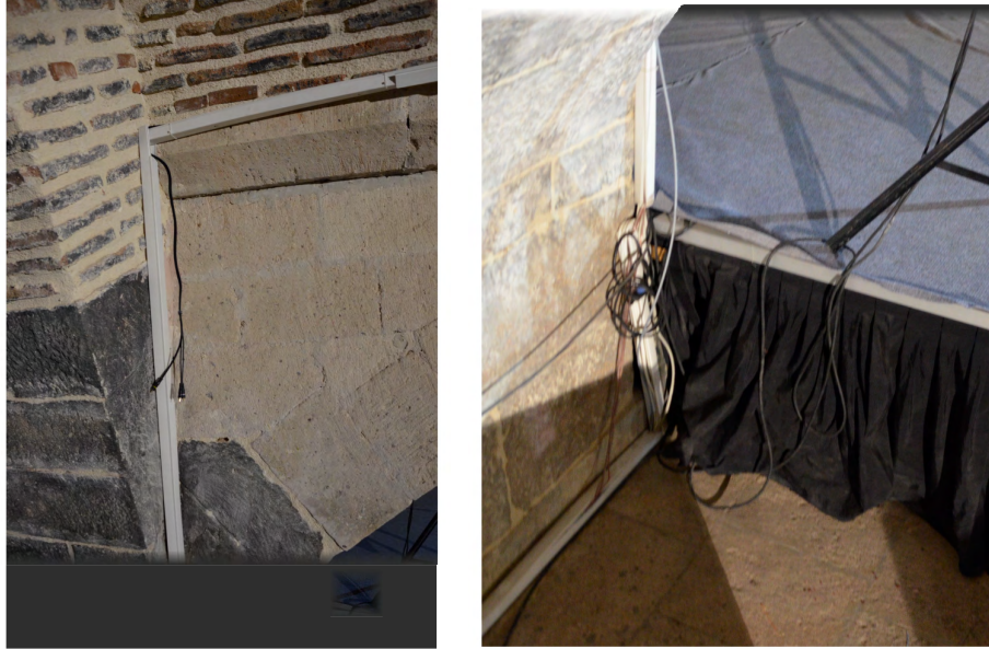
Görsel 26. Kervansarayda Elektrik Kablosu Detayları, 2015
