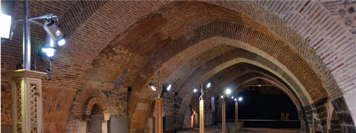
Görsel 32. Kervansarayın İs ve Mantardan Temizlenmiş Görüntüsü, 2015
