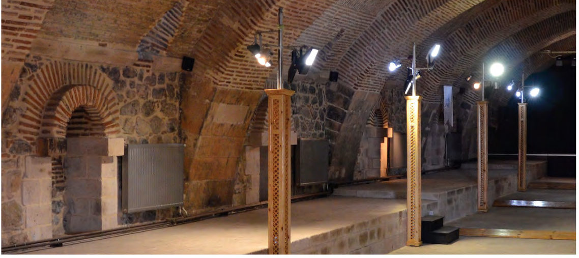
Görsel 30. Kalorifer Peteklerinin Sekilerin Cephesindeki Etkisi, 2015
