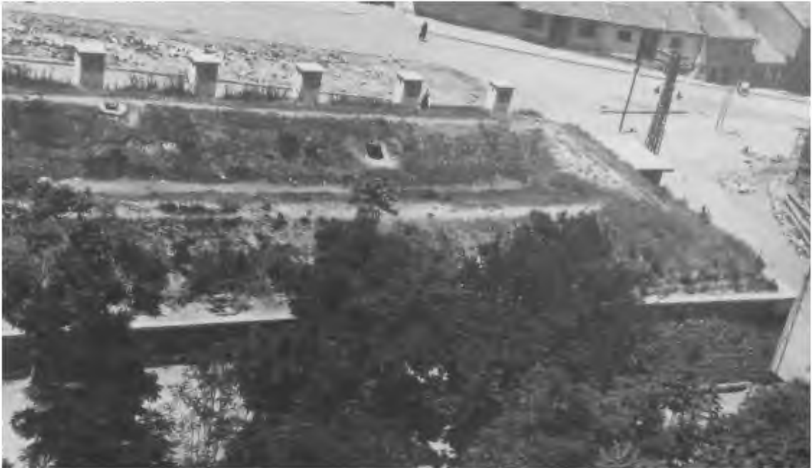
Görsel 29. Kervansarayın Toprak Çatı Örtüsü, 1960-1969
