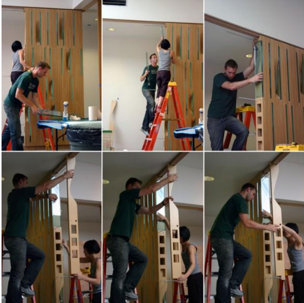
Resim 66 Slayt Kütüphanesi Doğu duvarının montajı
