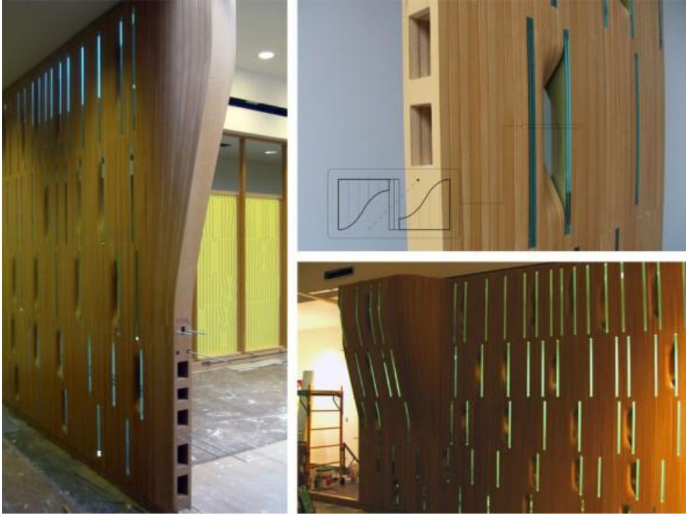
Resim 62 Slayt Kütüphanesi duvarları için üretilen prototipler ve içlerinde açılan boşluklar
