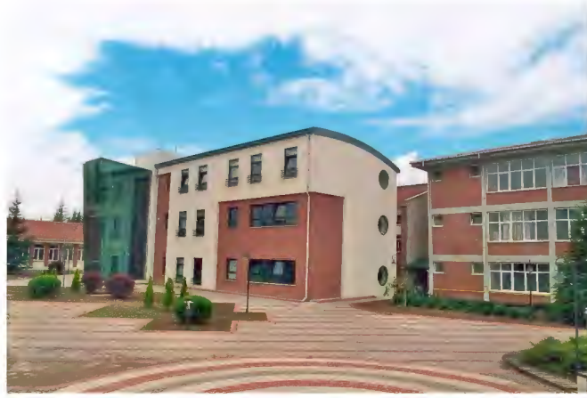
Resim 24: Baskı Sanatları Bölümü Binası.
