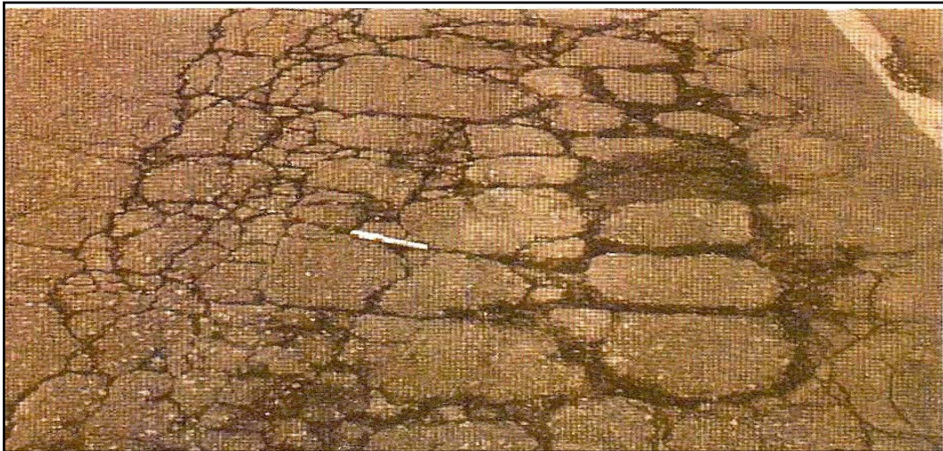
Şekil 5.14. Malzeme cinsi açısından kötü kaliteli malzeme ile yapılan yol üstyapısının bozulmasına ilişkin örnek (Timsah sırtı bozulma) [9]
