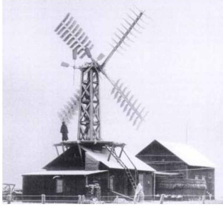
Şekil 3.2. Poul la Cour'un elektrik üreten ilk rüzgâr türbini [2]
