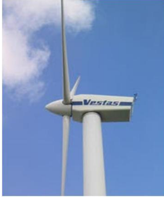
Şekil 3.11. Yatay eksenli üç kanatçıklı modern bir rüzgâr türbini [36]
