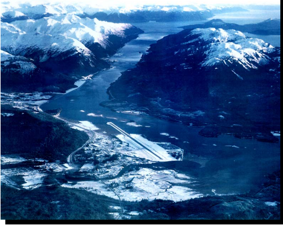
Şekil 2.16. Juneau Uluslararası Havaalanı [10]
