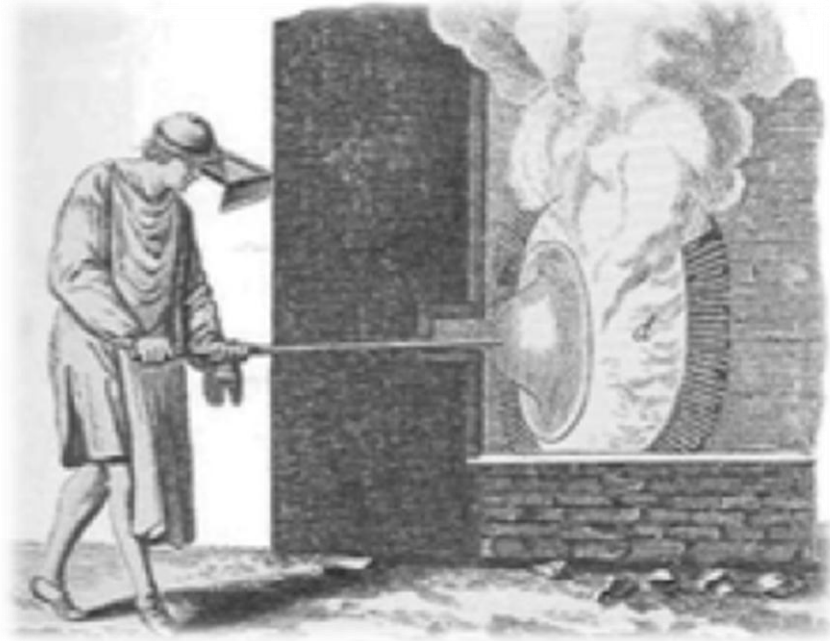
Şekil 1.1. 1750 yılında uygulanan cam üretim tekniğine bir örnek [3]
