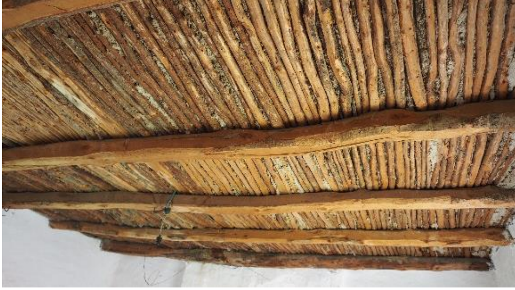
Şekil 4. 33. Yörökkırka Köyü'nde Ahşap ve Saman Katkılı Toprak ile Oluşturulan Döşeme Kurgusu
