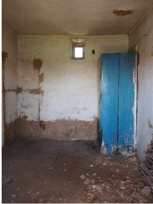
Şekil 4. 6. Kuzey Cephede Yer Alan Havalandırma Penceresi
