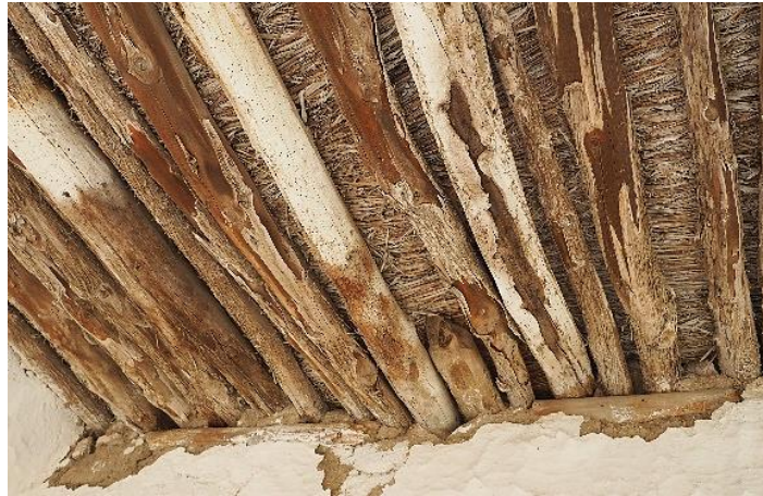
Şekil 4. 15. Ahşap ve Sazlarla Oluşturulan Çatı Kurgusu
