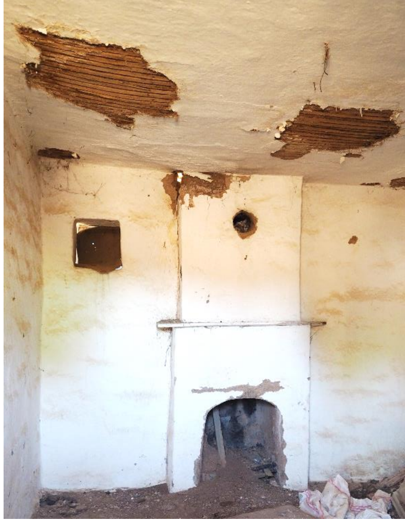
Şekil 4. 4. Sofada Bulunan, Isınma ve Yemek Pişirme Amaçlı Kullanılan Ocak
