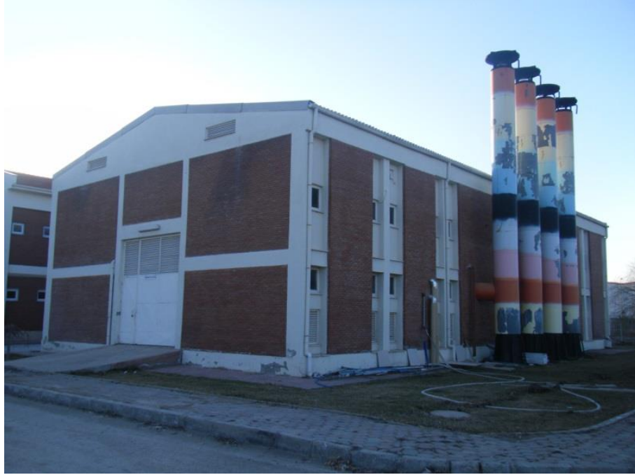
Şekil 3.14. Mühendislik Fakültesi bloklarına ait ısı merkezi
