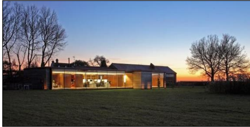
Şekil 4.36. Eski ahır yapısı ve sonradan eklenen ofis yapısı, (URL-24)
