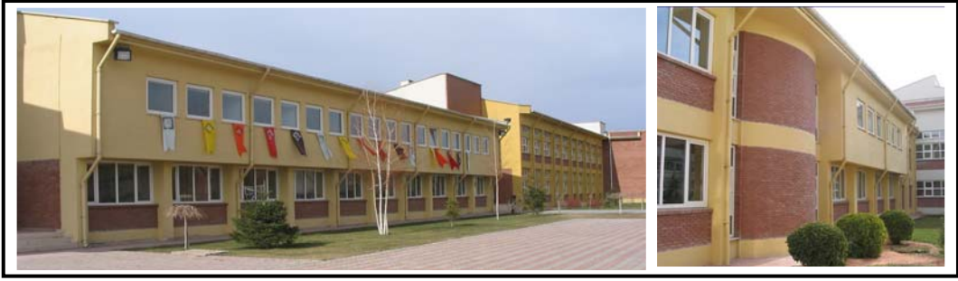
Şekil 4.5. A.Ü. Mimarlık Bölümü Binasının fotoğrafları
