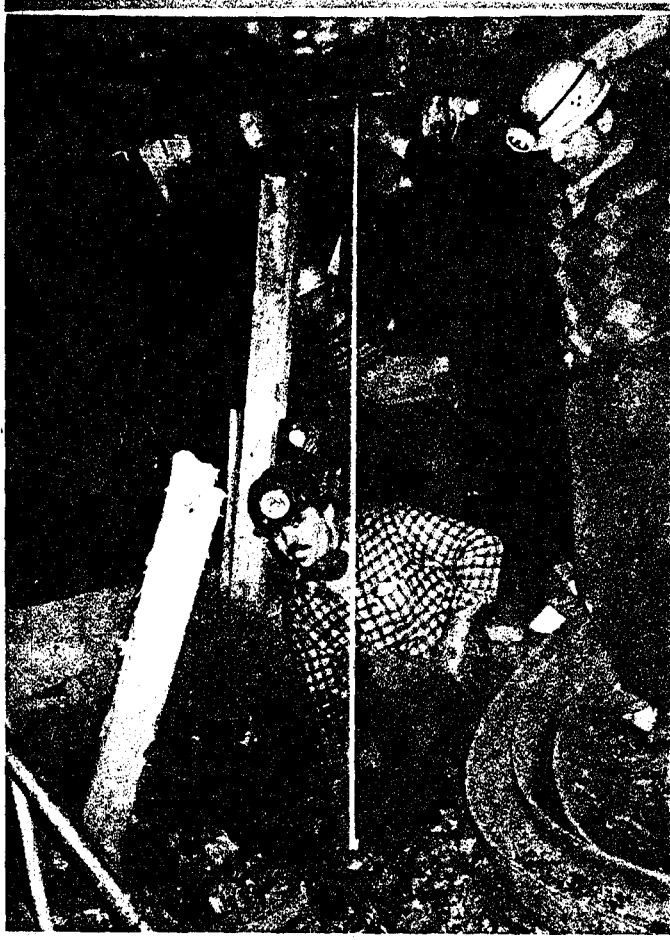
Şekil 7.5. Galerilerde konverjansın ölçülmesi.
