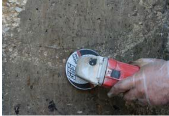
Görsel 5.3. Parlak yüzeylerin pürüzlendirilmesi [31].
