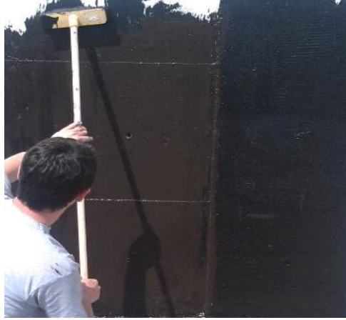
Görsel 4.5. Bitüm-çimento esaslı su yalıtım malzemesi uygulaması [30].
