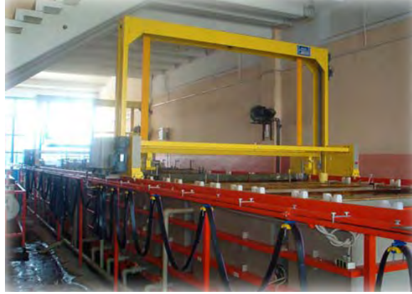
Şekil 4.1. Çinko Kaplama Tesisi
