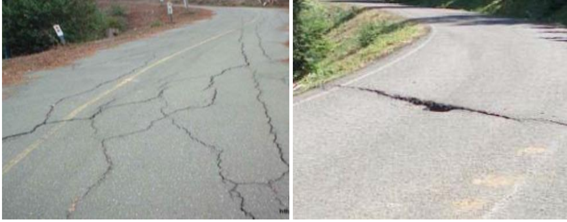
Şekil 3.2. Karayollarında zemin iyileştirme gerekliliği
