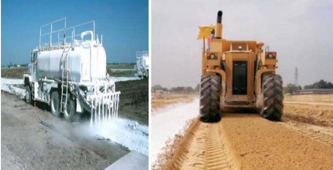
Şekil 3.3. Kireç ile stabilizasyon
