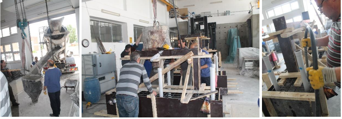
Görsel 3.14. Temel betonu dökümü
