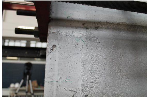
(b) Kolondaki ilk kesme çatlağı
