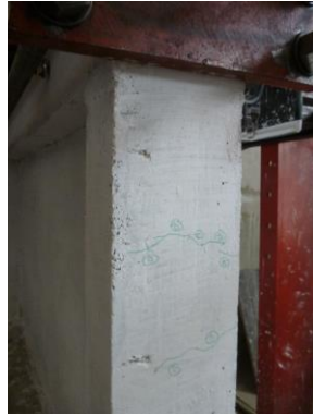
(a) Kolondaki ilk eğilme çatlakı
