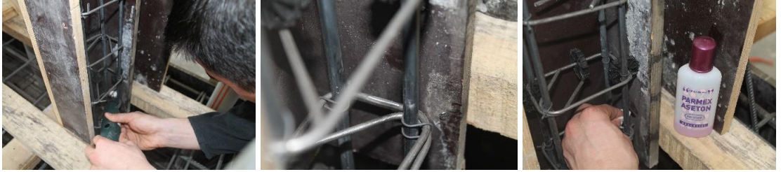
Görsel 3.10. Birim deformasyon ölçer yapıştırılacak bölgenin temizlenmesi
