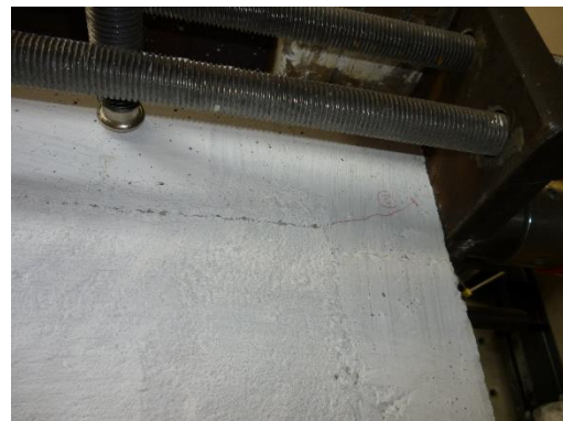
(b) Birleşim bölgesindeki ilk çatlak
