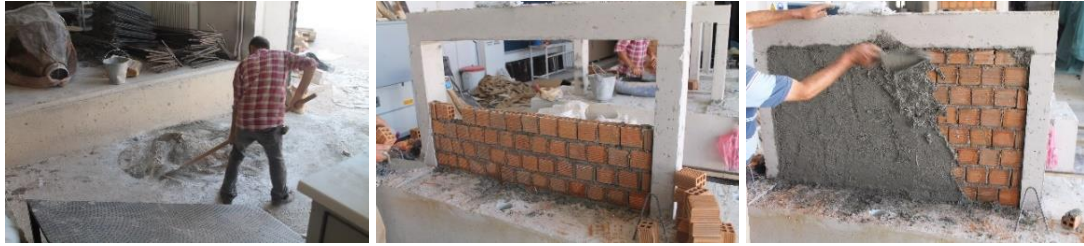
Görsel 3.5. Harç ve sıva uygulaması
