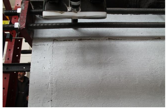
(b) Duvarda gözlenen ezilme
