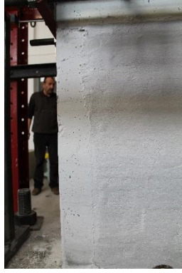
(a) Duvarda gözlenen ayrılma
