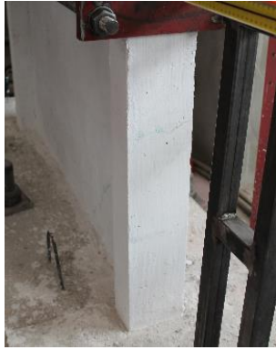
(a) Kolondaki ilk eğilme çatlağı
