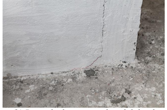
(b) Duvarda dönmeye neden olabilecek hasar
