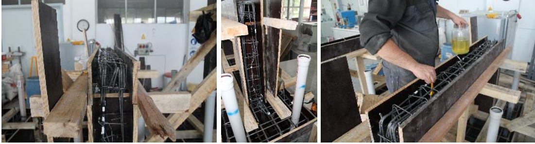
Görsel 3.13. Kablolara koruma bandı yapıştırılması ve kabloların kalıptan çıkarılması
