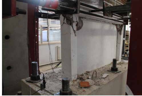
(c) Son çevrimdeki duvar hasarı
