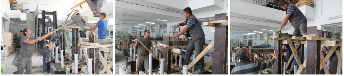
Görsel 3.15. Kolon kiriş beton dökümü
