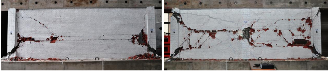
Görsel 2.13. Tam dolu dolgu duvarlı numunelerde kesme hasarları
