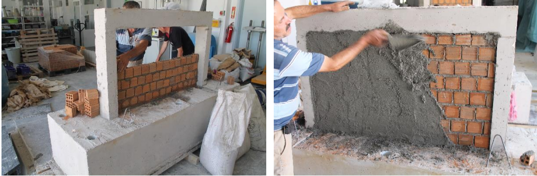
Görsel 3.16. Duvar imalatı ve sıva
