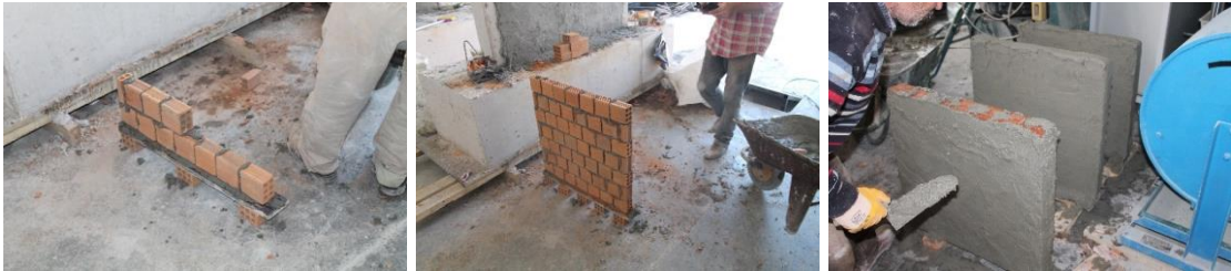
Görsel 3.17. Panel deneyleri için duvar imalatı ve sıva
