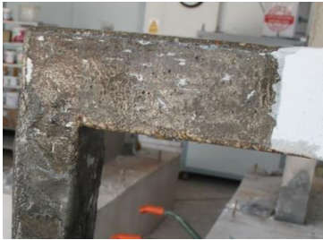
(d) Astar malzemesi uygulaması
