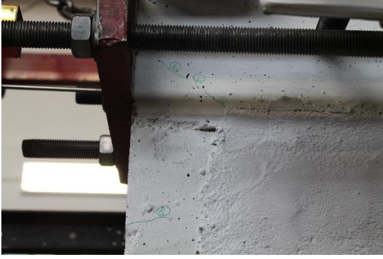
(a) Kolondaki ilk eğilme çatlağı
