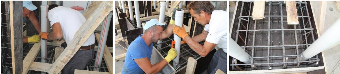
Görsel 3.9. Betonda boşluk kalacak yerlere plastik borunun sabitlenmesi
