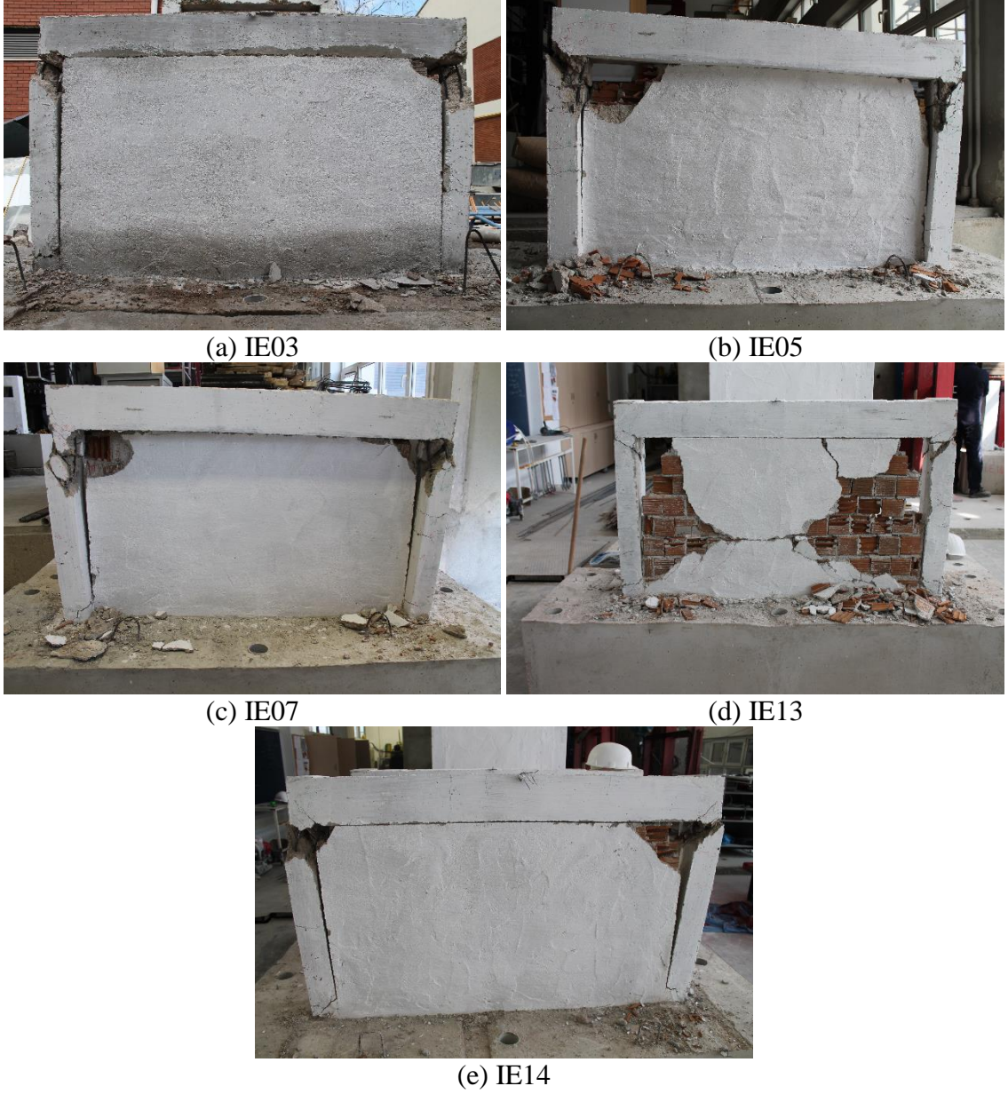
Görsel 4.63. Beklenmeyen kısa kolon hasarı gözlenen numuneler
