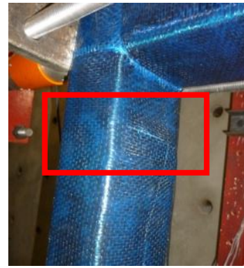
(b) CFRP katmanlarının şişmesi
