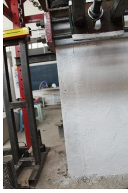
(a) Duvarda gözlenen ayrılma
