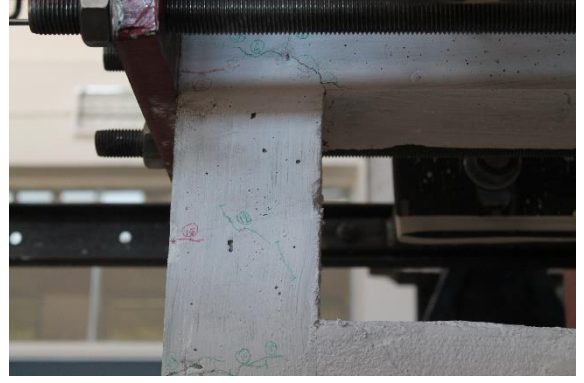
(b) Kolondaki ilk kesme çatlağı
