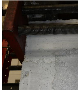
(b) Birleşim bölgesindeki ilk çatlak
