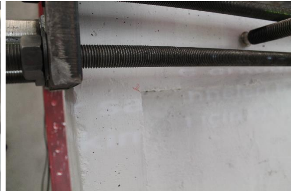
(b) Birleşim bölgesindeki ilk çatlak
