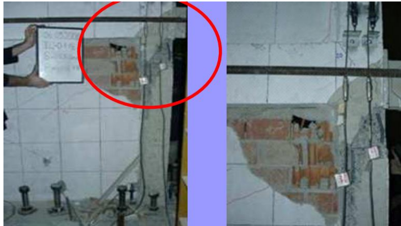
Görsel 2.8. Bindirmeli donatılı numunede dolgu duvar hasarı sonrası kolondaki kesme hasarı
