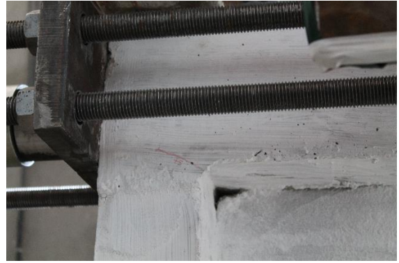
(b) Birleşim bölgesindeki ilk çatlak
