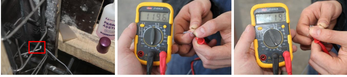
Görsel 3.12. Birim deformasyon ölçere koruma bandı yapıştırılması ve kablo kontrollerinin yapılması
