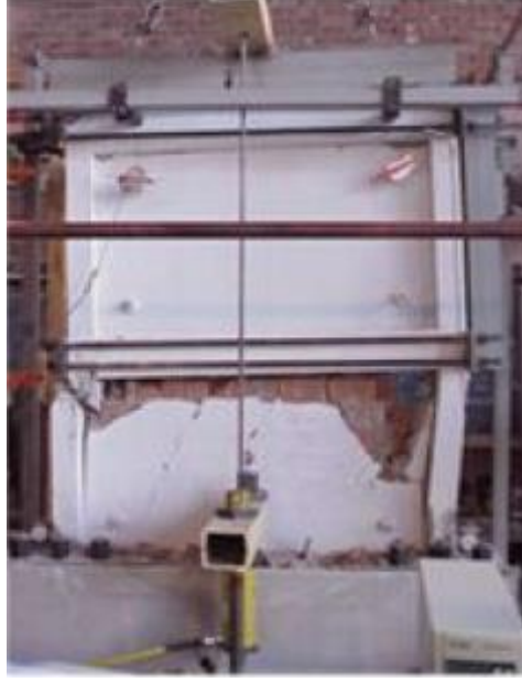
Görsel 2.10. Kolonda ilk katta gözlenen kesme hasarı
