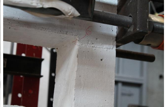
(b) Birleşim bölgesindeki ilk çatlak
