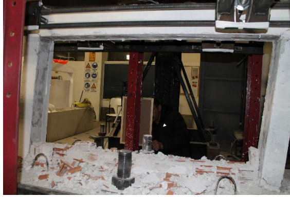
(c) Son çevrimdeki duvar hasarı
