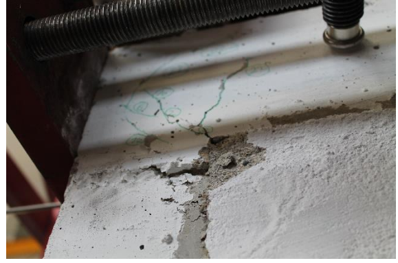
(b) Duvarda gözlenen ezilme
