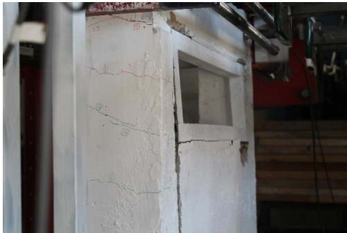
(a) Kirişteki ilk eğilme çatlağı
