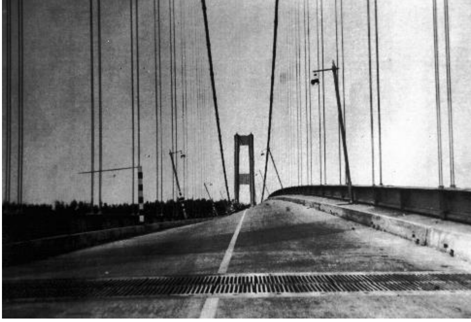
Şekil 3.1. Tacoma Köprüsünün rüzgâr etkisiyle oluşan salınımı
