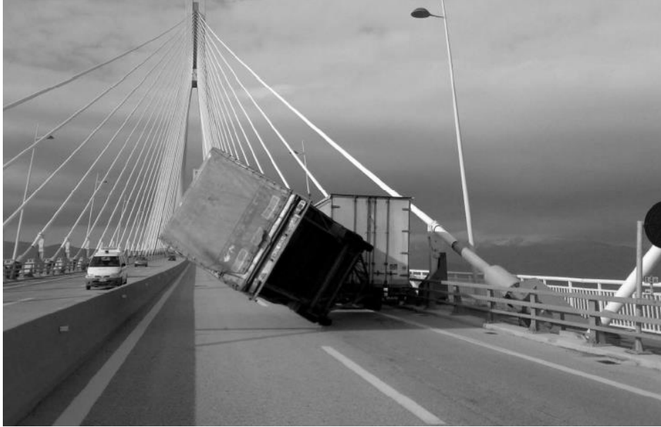
Şekil 8.1. Rion Antirion Köprüsü üzerinde rüzgar nedeniyle devrilmek üzere olan tır
