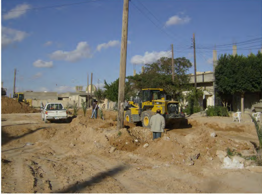
Şekil 9.7. Ajdabia Kuzey Bölgesi Altyapı projesinden bir görüntü-VII
