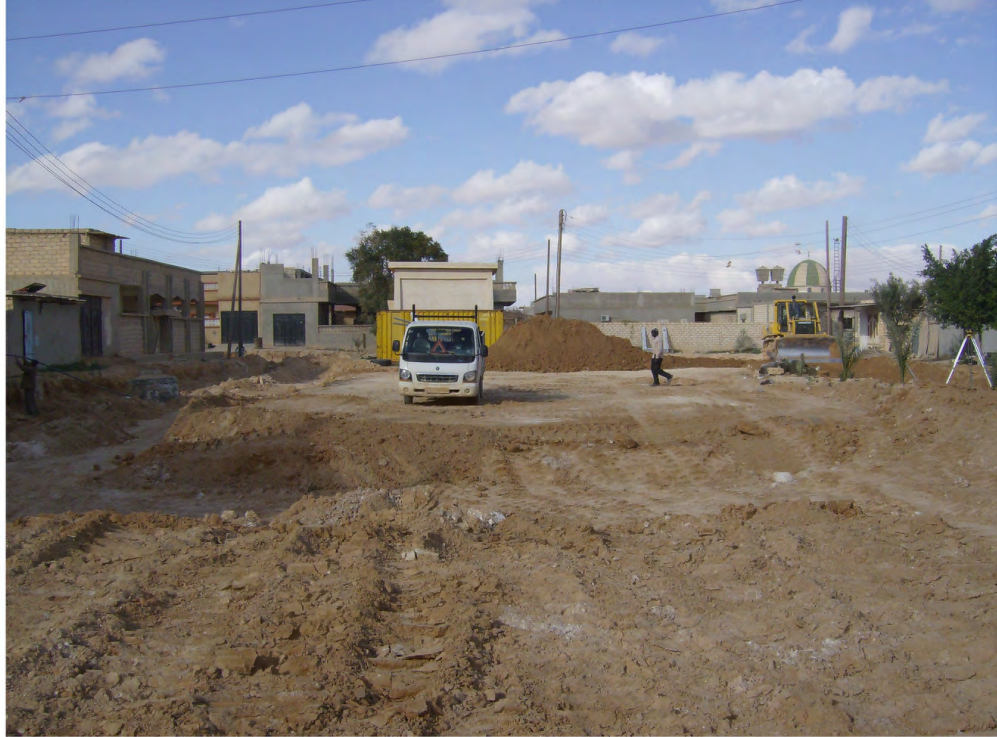
Şekil 9.6. Ajdabia Kuzey Bölgesi Altyapı projesinden bir görüntü-VI
