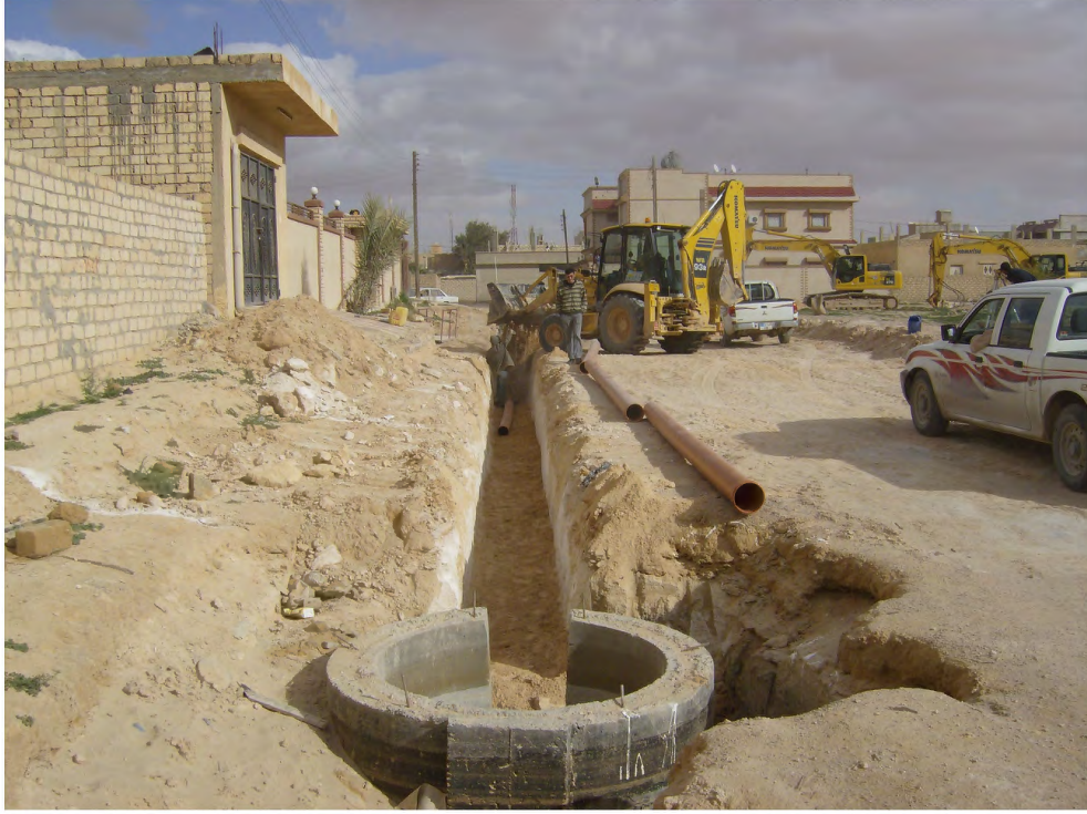
Şekil 9.1. Ajdabia Kuzey Bölgesi Altyapı projesinden bir görüntü-I
