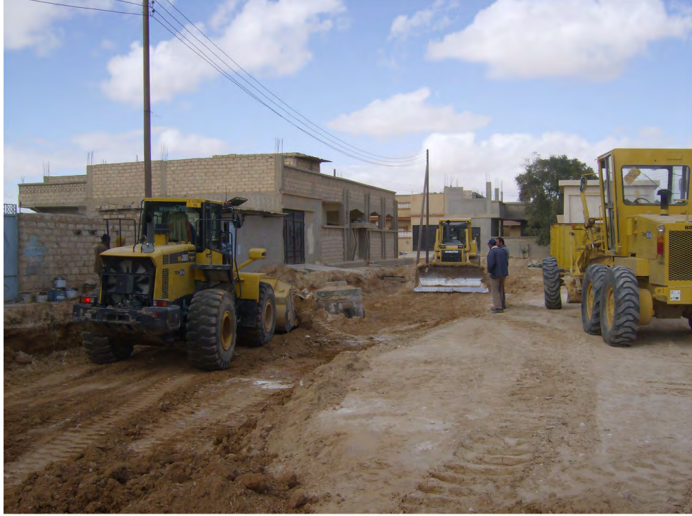
Şekil 9.4. Ajdabia Kuzey Bölgesi Altyapı projesinden bir görüntü-IV
