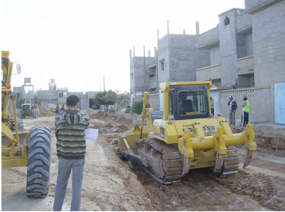
Şekil 9.3. Ajdabia Kuzey Bölgesi Altyapı projesinden bir görüntü-III
