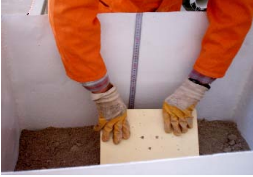
Şekil 5.13. Geçirimsizlik malzemesinin sıkıştırılmadan önce bölme içerisinde yayılması
