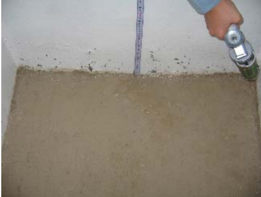
Şekil 5.17. Geçirimsizlik tabakasının kenarlarına silikon çekilmesi
