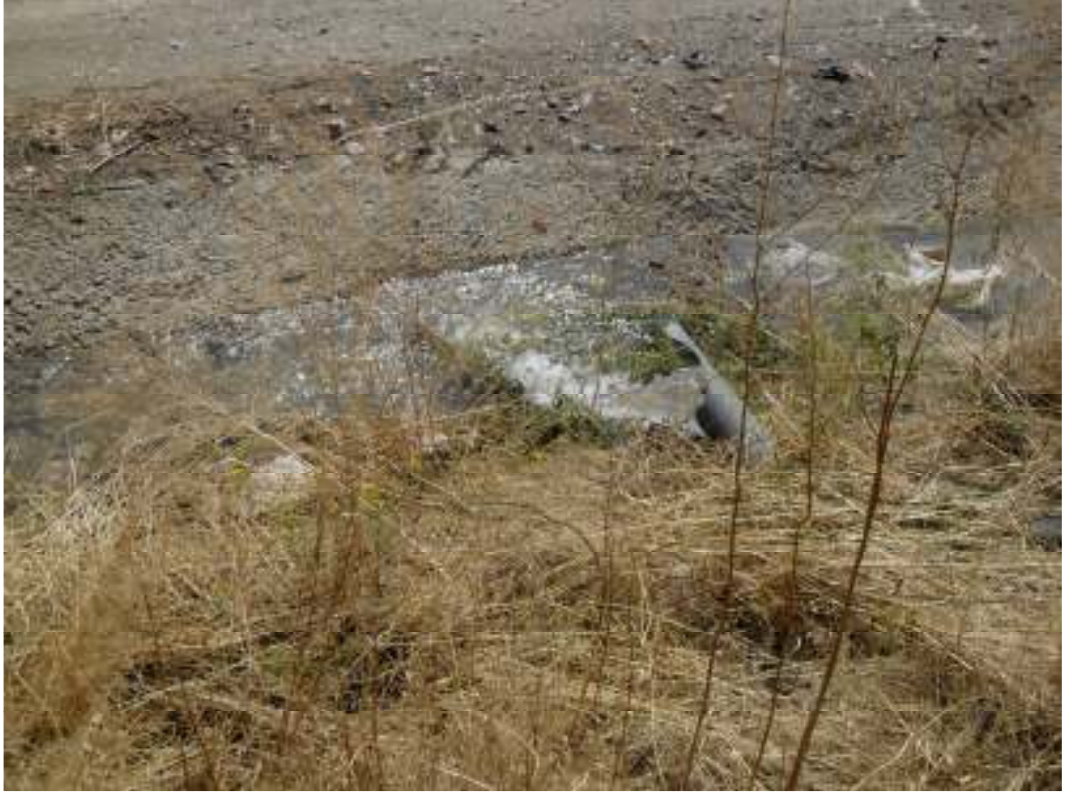
Ek-12 ay Belediyesi Beton Santrali (11 nolu kaynak)
