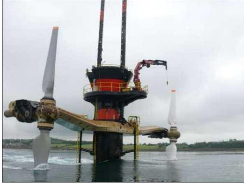
Şekil 2.8. Deniz Akıntısı Enerjisi Santrali
