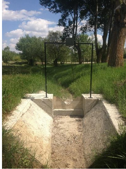
Şekil 6.9. Kaynak deresi üzerine inşa edilen savak
