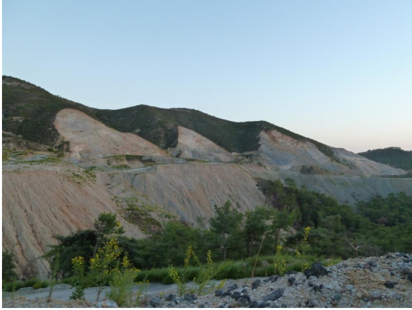
Şekil 5.4 Ören Beldesi çıkışı yol kenarı, Karagedik Mevkii, Mersin-Antalya karayolu inşaatının vejetasyon üzerinde yarattığı tahribatın görünümü.
