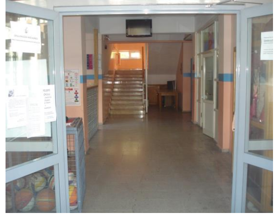
Fotoğraf 2.33. B-Blok Zemin Kat Koridoru
