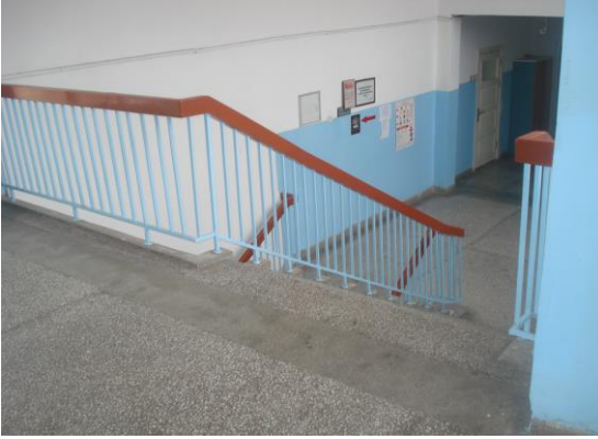
Fotoğraf 2.29. A-Blok D-Katına Çıkan Merdiven
