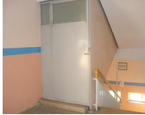
Fotoğraf 2.49. B-Blok 3. Kat Çatı Merdiveni
