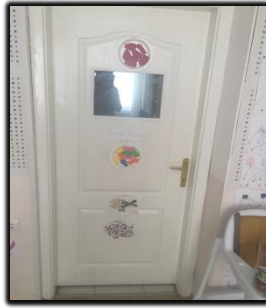
Görsel 2.15. ÖERM Sınıf Kapısı Cephesi
