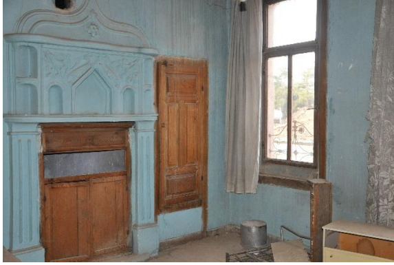
Şekil 7. Başodanın ocak nişi ve ahşap yüklüğü
