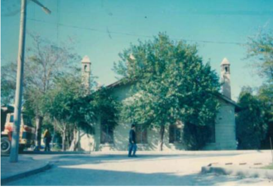
Resim: 3- Restorasyon Öncesi Genel Görünüm, 1998, (EKVKBK)
