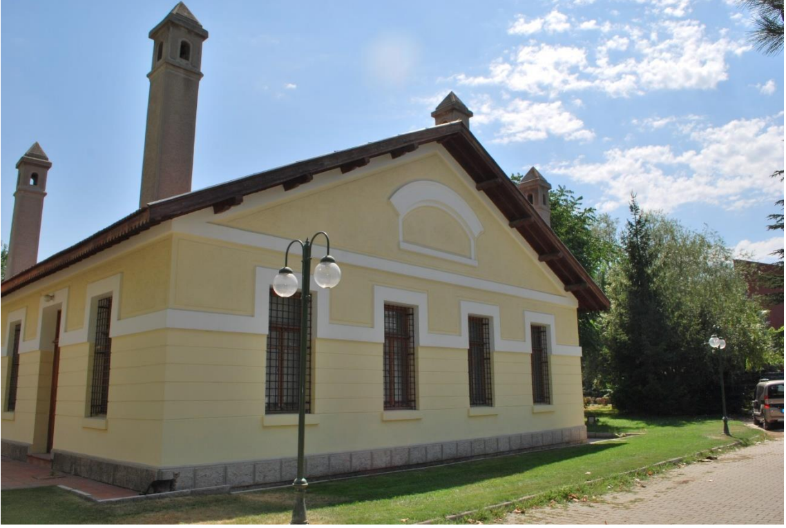
Resim: 10- Kuzey Cephe Restorasyon Sonrası,2023, (Derya Gözeyik)
