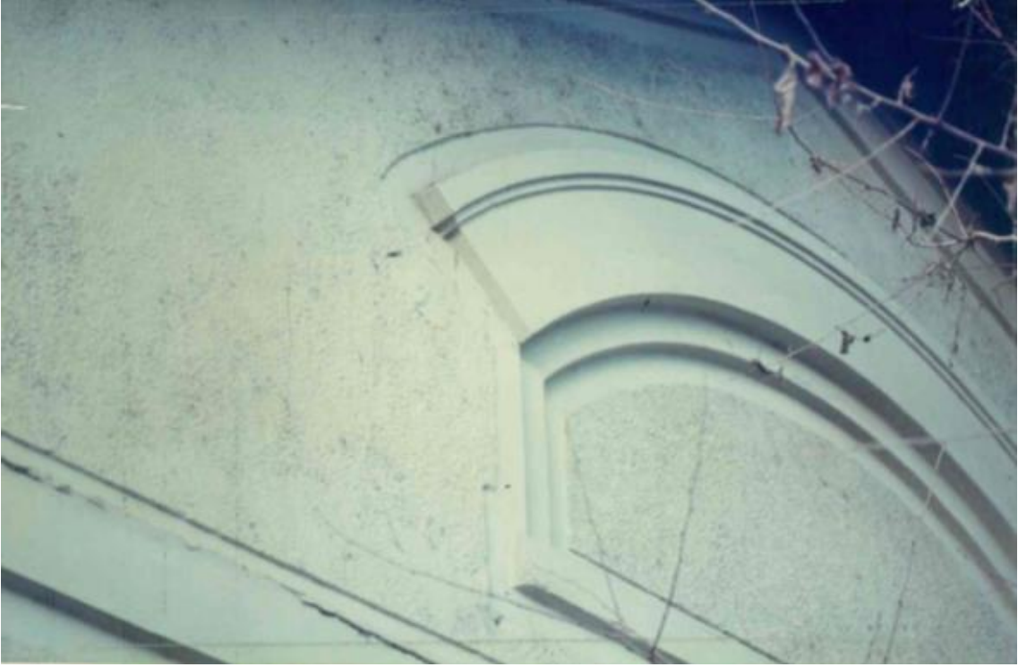
Resim: 11- Kuzey Cephe Restorasyon Öncesi, Ayrıntı, 1998, (EKVKBK)
