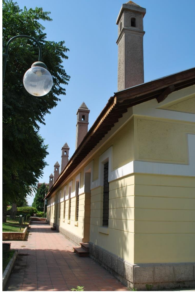
Resim: 22- Restorasyon Sonrası Çatı Kuleleri, 2023, (Derya Gözeyik)
