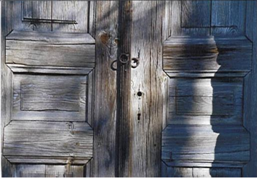
Resim: 37- Restorasyon Öncesi Kapı, 1998, (EKVKBK)
