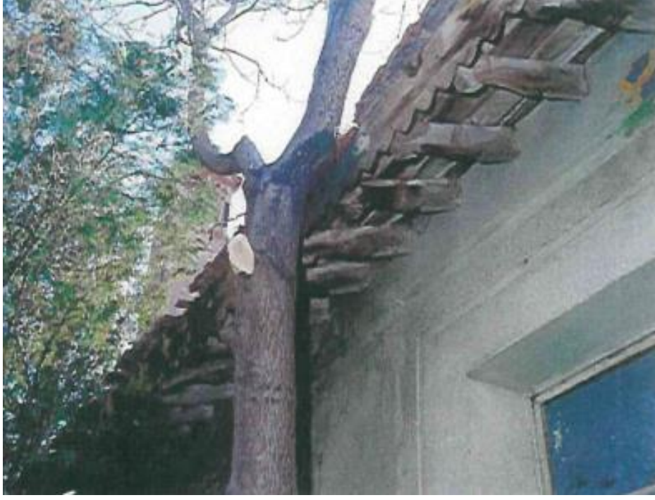
Resim: 16- Restorasyon Öncesi Çatı Saçağı, 1998, (EKVKBK)
