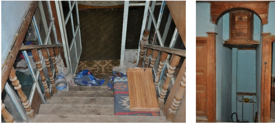
Şekil 5. İkinci kata çıkan ahşap merdiven ve giriş açıklığı
