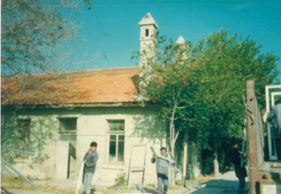
Resim: 4- Restorasyon Öncesi Genel Görünüm, 1998, (EKVKBK)
