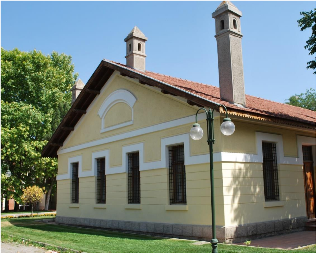
Resim: 9- Kuzey Cephe Restorasyon Sonrası, 2023, (Derya Gözeyik)
