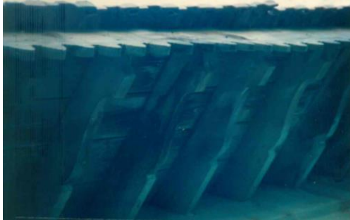
Resim: 15- Restorasyon Öncesi Çatı Saçağı, 1998, (EKVKBK)
