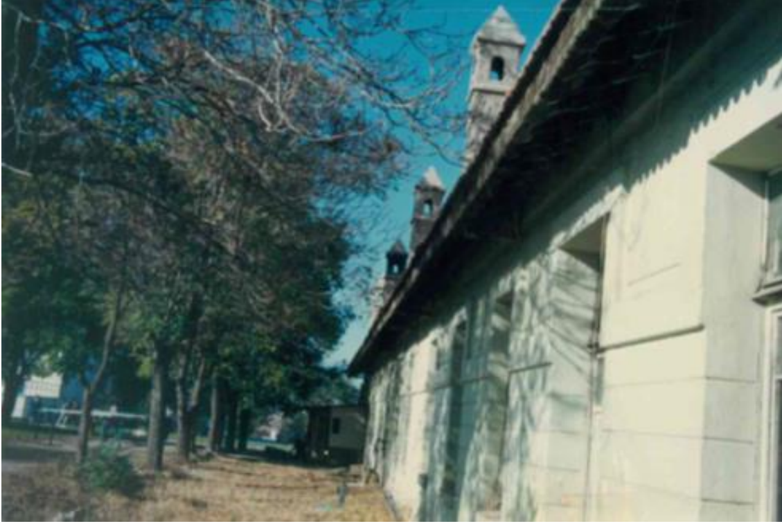
Resim: 5- Restorasyon Öncesi Genel Görünüm, 1998, (EKVKBK)
