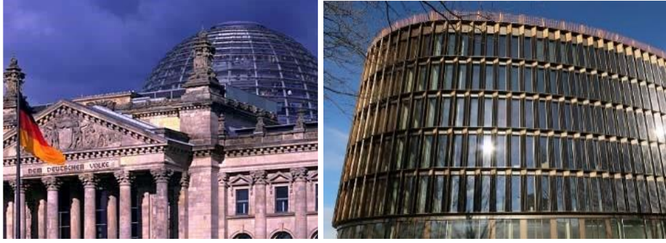
Görsel 3.12. “Reichstag Alman parlamento Binası” (sol) ve “Freiburg Belediyesi Teknik İşler Binası” (sağ) 29
