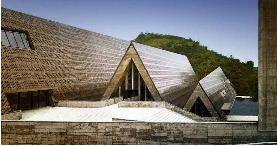
Görsel 1.62. Shui Kültür Merkezi, yapının çatısında bulunan delikli bronz plakalar, West-Line Studio
