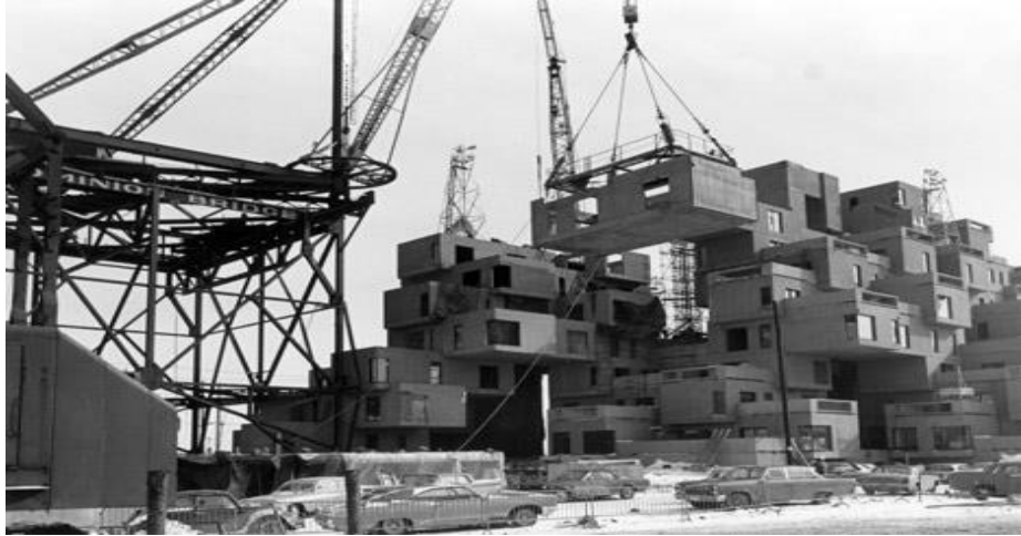
Görsel 1.34. Habitat 67 yapım aşaması, Moshe Safdie
