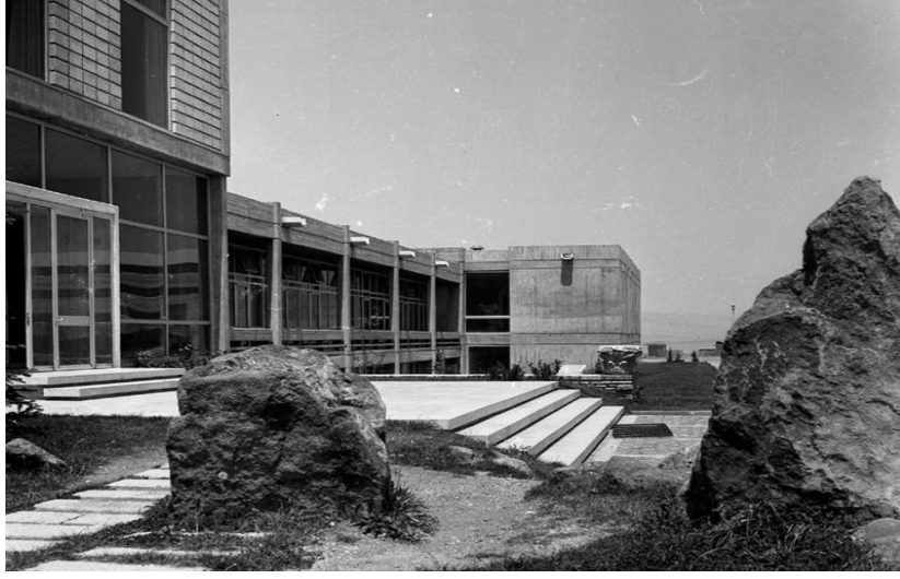
Görsel 1.86. Orta Doğu Teknik Üniversitesi Mimarlık Fakültesi, giriş kapısı, Behruz Çinici, Altuğ Çinici
