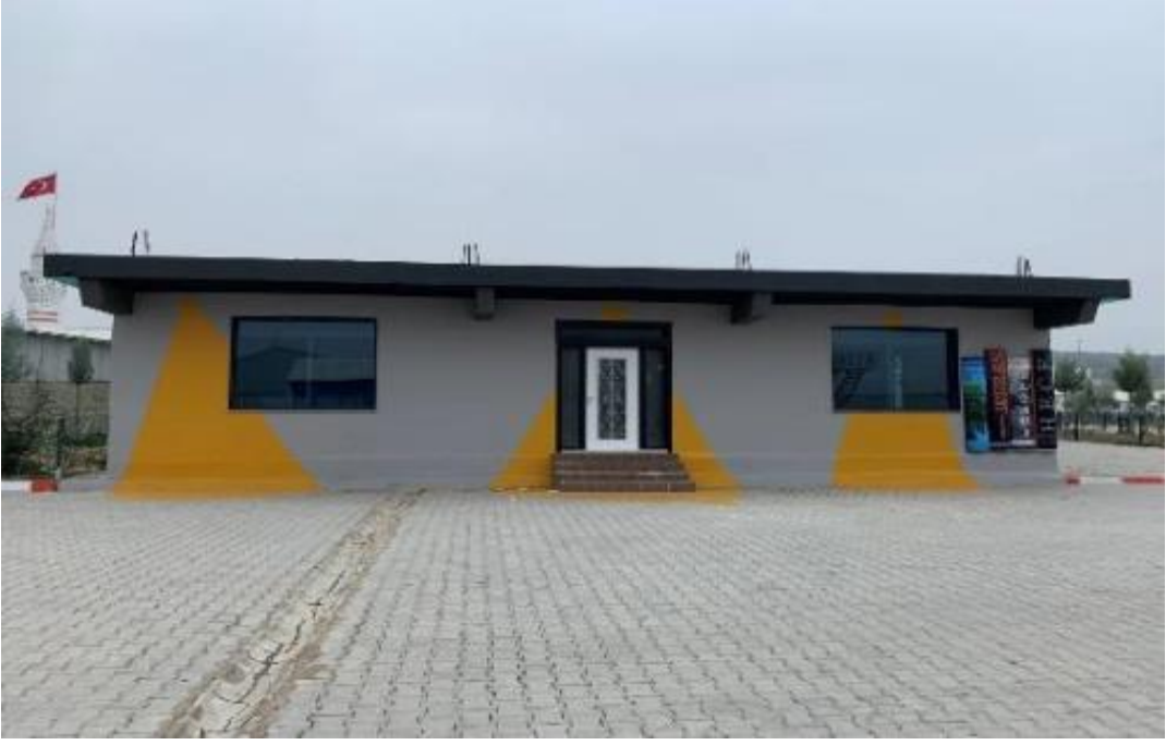
Görsel 36. Geçici Barınma Merkezi İçerisindeki Kütüphane
