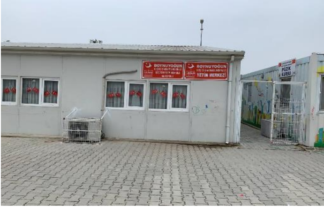
Görsel 37. Geçici Barınma Merkezi İçerisindeki Ana Okul ve Yetim Merkezi
