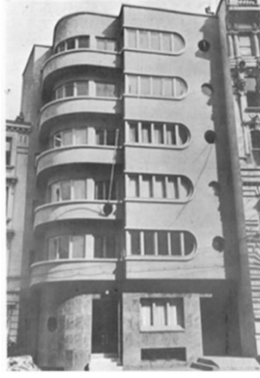
Görsel 5.21. Adil Denктаş tasarımı Tüten Apartmanı, 1936 (Denктаş, 1936)
