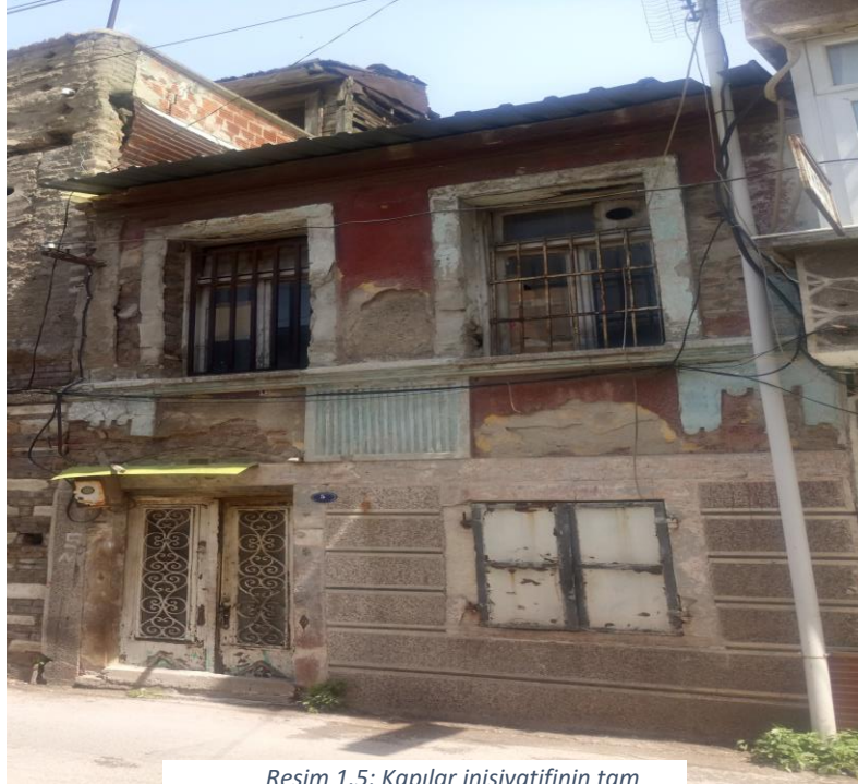
Resim 1.5: Kapılar inisiyatifinin tam karşısında, Hüseyin Ustanın atölyesi.
