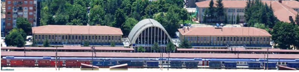
Şekil 14. Gar Binası arka cephe (Can Düz)
