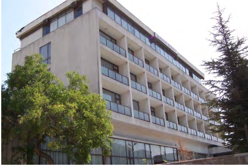
Şekil 25. Eskişehir Emek Oteli (R. Karasözen, 2004)
