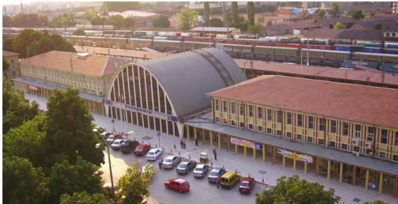
Şekil 13. Gar Binası (G. Koca, 2009)
