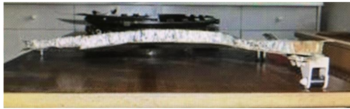
Görsel 4.8. A/İ/T iç kapağındaki deformasyon
