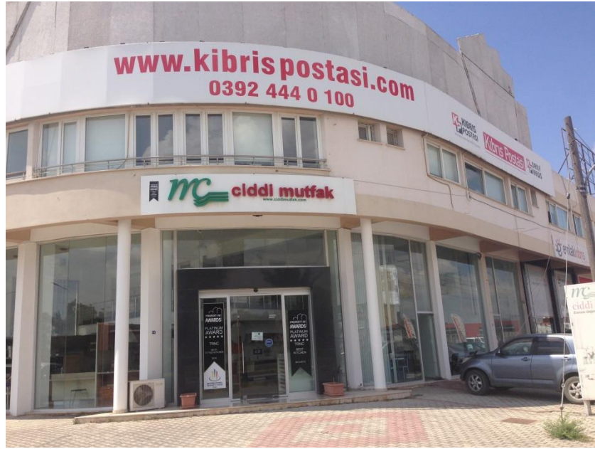
Görsel EK-3.4. Kıbrıs Postası gazetesi binası.
