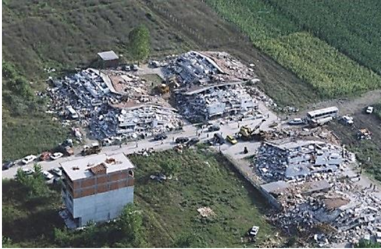
Şekil 1. 1999 Kocaeli depreminde Gölcük yerleşim yerinden bir fotoğraf [7]
