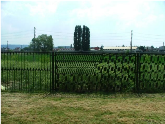
Resim 12. Atık demir panolardan oluşturulan düzenler sınır elemanları.
