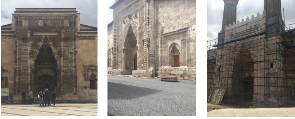
Resim 6: Buruciye Medresesi, Çifte Minareli Medrese ve Gökmedrese taçkapılarını gösteren fotoğraflar (27.04.2016).
