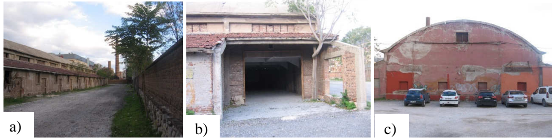
Şekil 16. a) Çiftkurt Kiremit Fabrikası güney cephesi, b) Çiftkurt Kiremit Fabrikasının halen açık olan güney cephesi servis girişi, c) Çiftkurt Kiremit Fabrikası batı cephesi [14].
