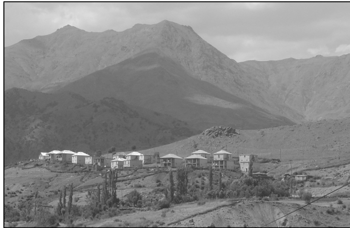
Şekil 5. KDRP kapsamında Tur Mezrası'nda inşa edilen konutların genel görünümü (20 konut)
