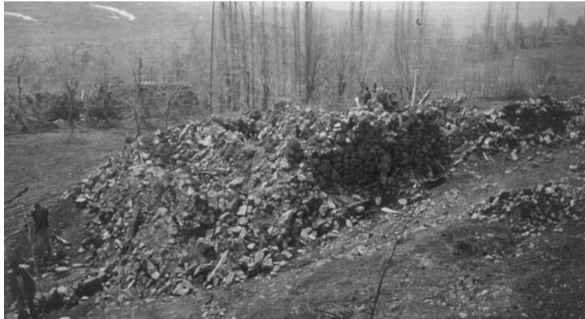
Yıkılmış bir ev, Tur Mezrası
