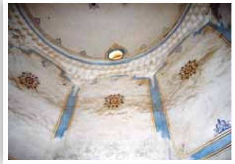
Resim 3: Üryan Baba Türbesi Kubbe Geçişleri (2010)
