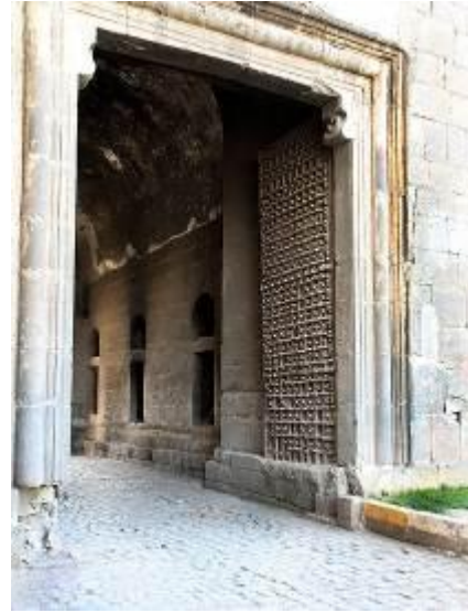
Resim 3: Artuklu Dönemi Kuzey Kapı-geçiş mekânı
